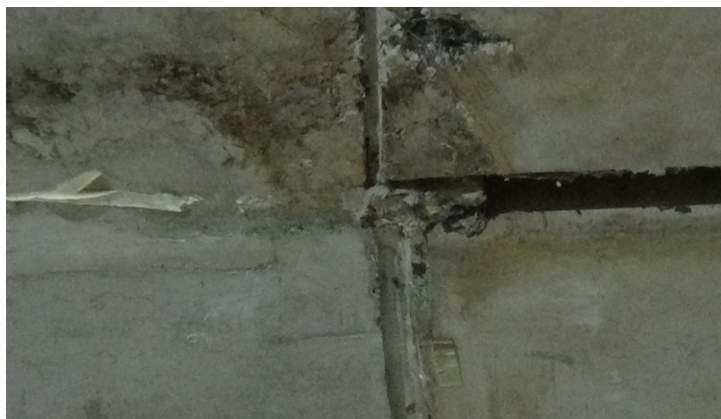
Decke der DB-Lounge (Stuttgart 21)
