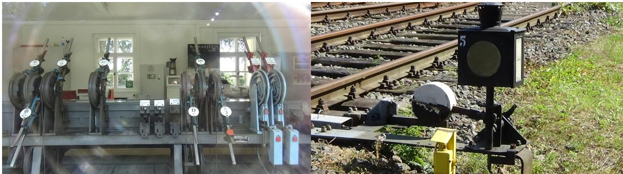
Im Bahnhof Schlettau zum Beispiel werden die Weichen noch heute von einem Handhebelstellwerk aus über Seilzüge gestellt. Einige Weichen werden sogar noch von Hand bedient, wie das rechte Foto zeigt. Von Digitalisierung also keine Spur.
