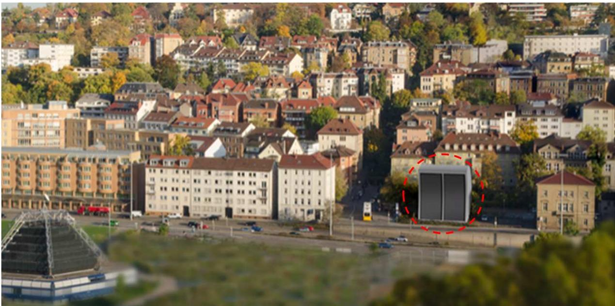
Abb. 6.1.1 Luftansaughutze Schwallbauwerk Süd zur Entrauchung Tiefbahnsteighalle
