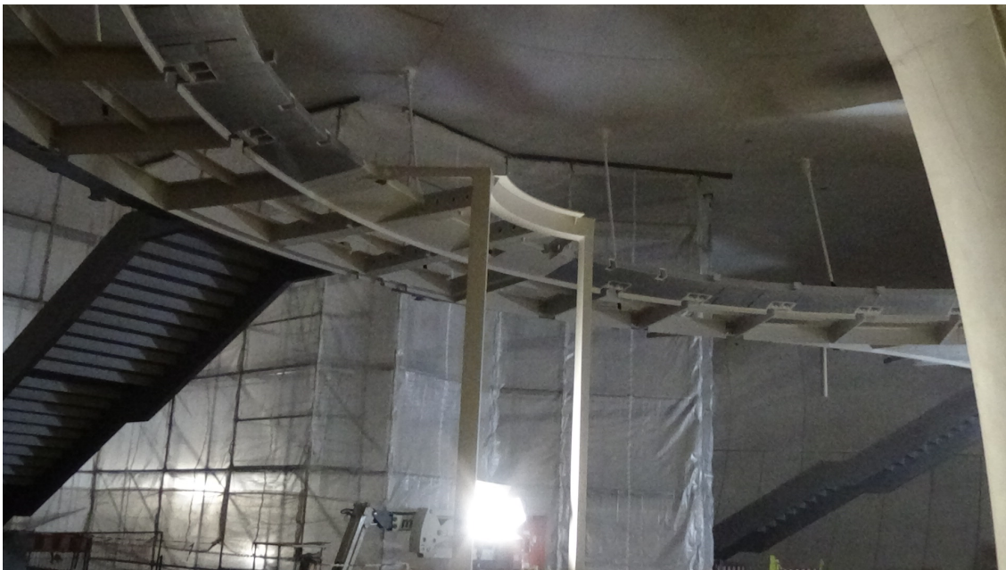
Verteilerebene mit Zugang zum künftigen Personenaufzug in der Bildmitte
