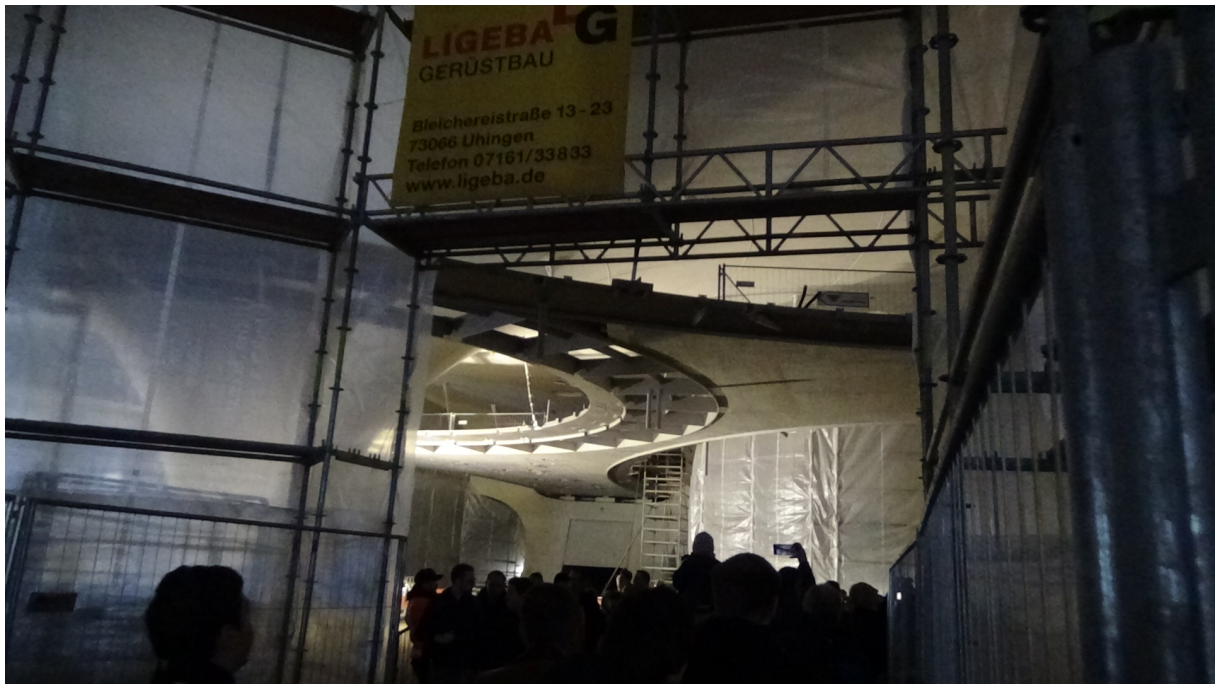
Südliche Verteilerebene mit Verbindung zur Haltestelle Staatsgalerie (hinten im Bild)
