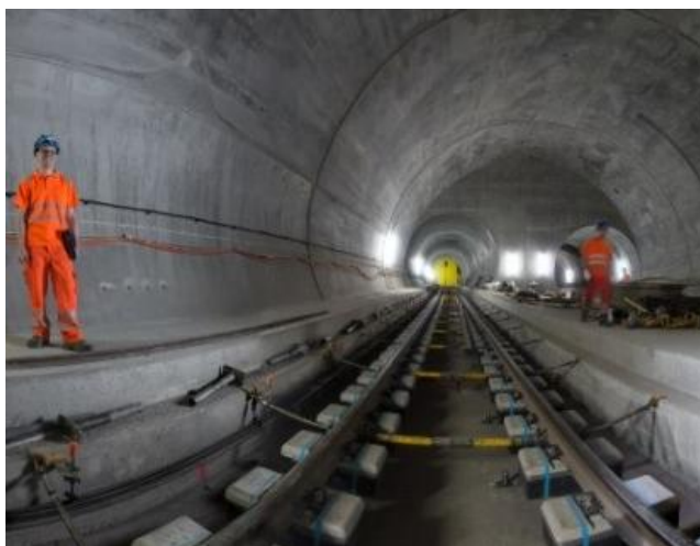
Abb. 01 Gotthard-Basistunnel mit durchlaufend auf Ausstiegshöhe angehobenem Fluchtweg
